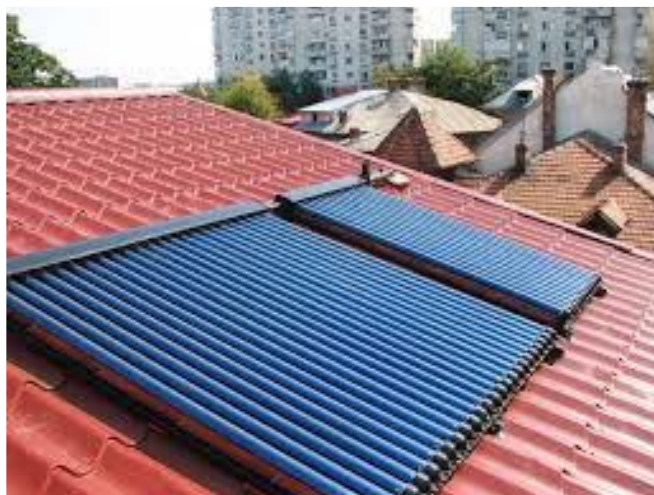
Figura 18 - Panouri solare – pentru apa calda
