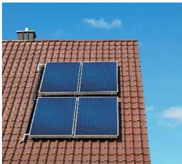
Figura 19 -Panouri fotovoltaice pentru producere energie electrica
